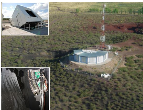
Figura 9. Edificio del telescopio de FD, el recuadro superior se muestra HEAT y en la inferior un telescopio con el espejo y los PMT's.
